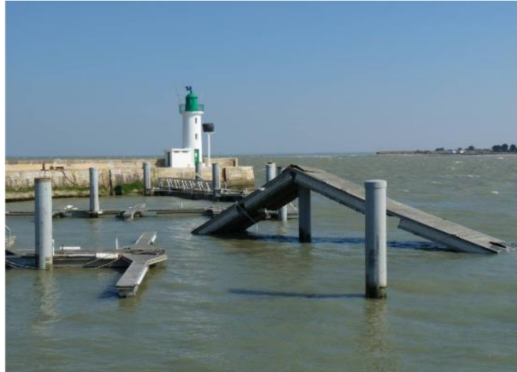
Figure vi. Dommages sur des structures portuaires (île de Ré, en Charente-Maritime, port de La Flotte (BRGM (2010))
