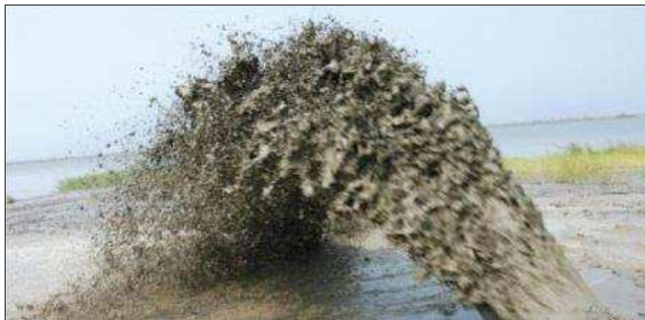
Figure 1.1-2. Boues de dragage en sortie de drague pour une mise en dépôt
