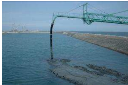
Figure 3.4-11. Mise en place du sédiment solidifié
