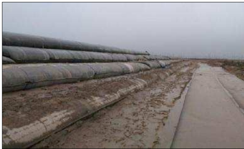
c) Remplissage de la digue
