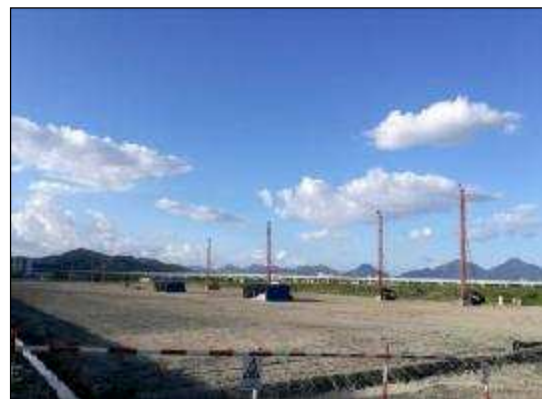
Après la construction
