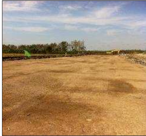
Après la construction
