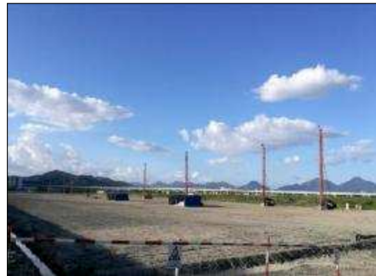
Après la construction
