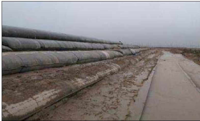
c) Remplissage de la digue
