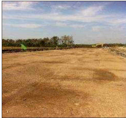
Après la construction
