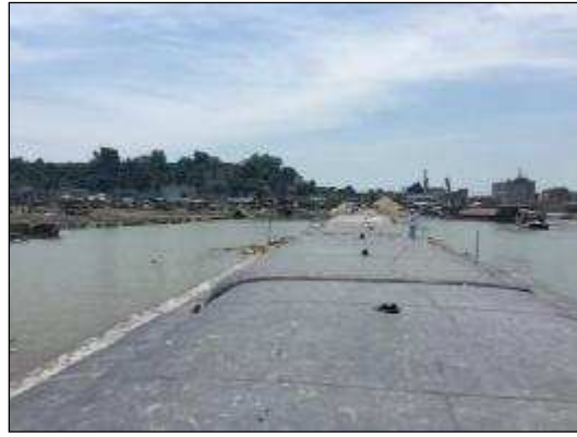
b) Sédiment solidifié l'intérieur de géotextile
