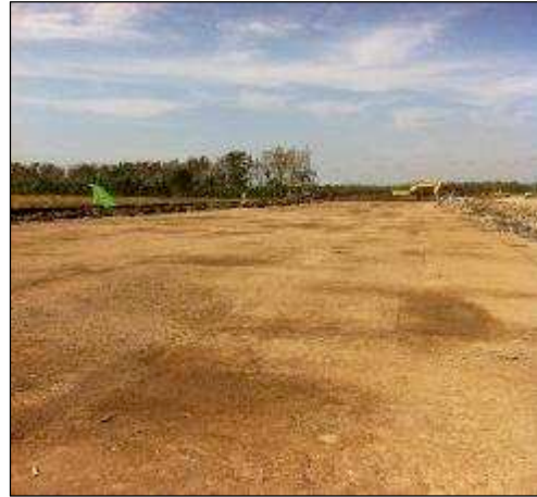
Après la construction
