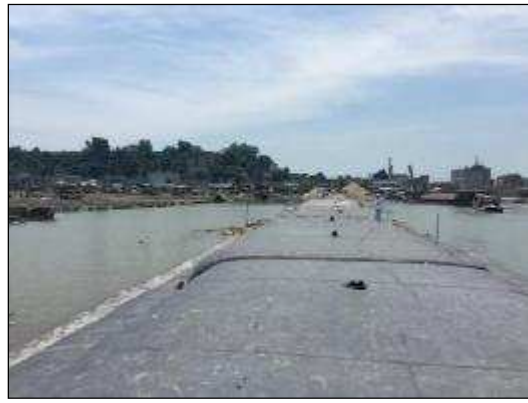
b) Sédiment solidifié l'intérieur de géotextile
