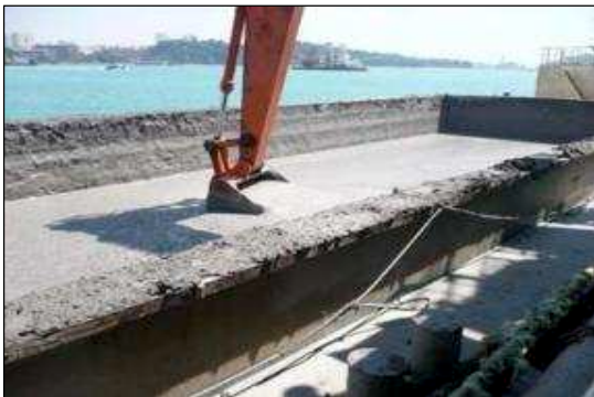
Figure 3.4-10. Mélange du sédiment en barge
