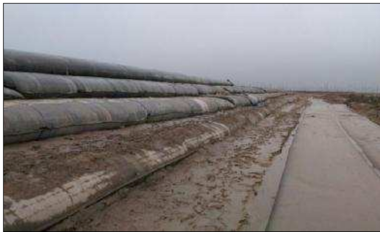
c) Remplissage de la digue
