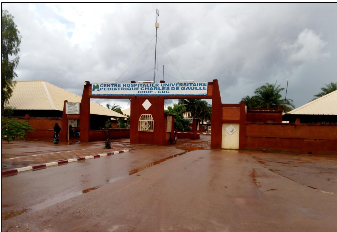
Figure 16 : Vue de l'entrée du CHUP-CDG
