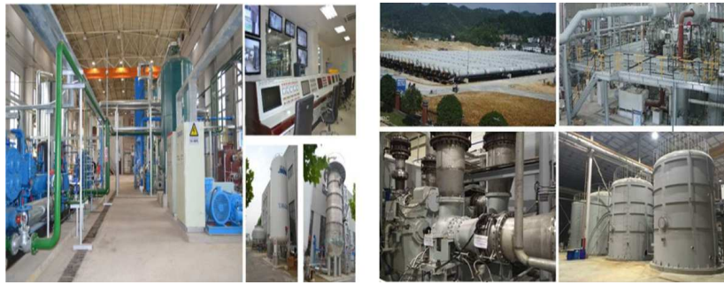
FIGURE 1.20 : Centrale pilote chinoise de stockage d'électricité par air comprimé supercritique (à gauche) et adiabatique avancé (à droite) [14]
