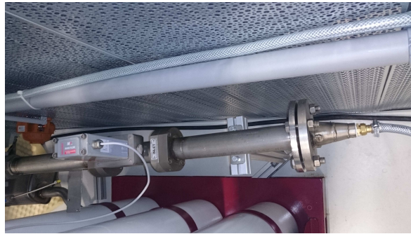
FIGURE 3.14 : Photo du système portant le débitmètre situé à l'entrée du moteur pneumatique (point de mesure FT05 du diagramme d'instrumentation)
