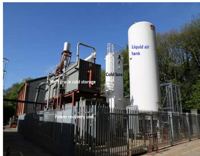
FIGURE 1.19 : Photo de l'installation pilote de stockage d'électricité par Air Liquide de Birmingham [14]
