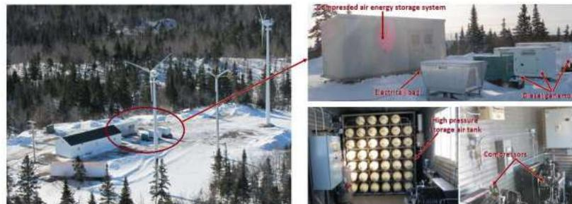
FIGURE 1.28 : Micro réseau expérimental utilisant le concept hybride éolien/diésel avec stockage d'air comprimé construit par TechnoCentre éolien au Canada [20]
