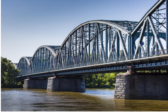
FIGURE 1.3 – Pont de Torun en Pologne : pont en treillis
