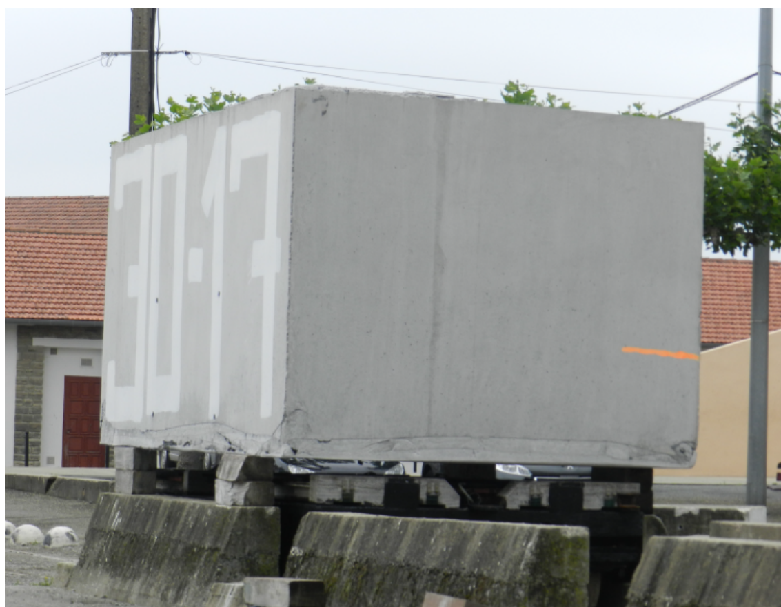
FIGURE 5.9 – Bloc de béton utilisé pour renforcer la digue de l'Artha en vue de l'hiver suivant.
