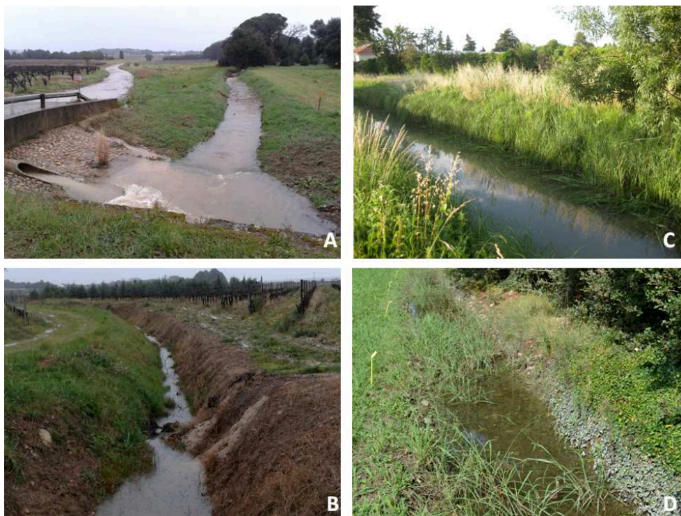
FIGURE 1.2 – Illustrations de canaux et fossés en zone méditerranéenne : A) Fossé en zone viticole bordant une route B) Fossé en zone viticole entre 2 parcelles C) Canal de drainage D) Canal d'irrigation en zone de prairies
