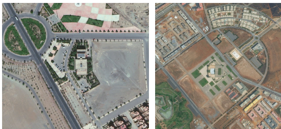
Figure 106 : Exemples d'équipements publics à Tamansourt (1 : Société d'aménagement Tamansourt), et à Tamesna (2 : Mosquée et centre de conférences)
