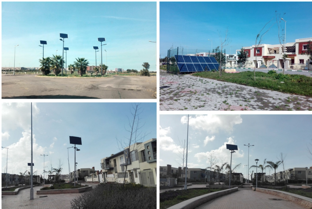
Figure 77 : Systèmes et dispositifs solaires et photovoltaïques à Sahel Lakhiayta
