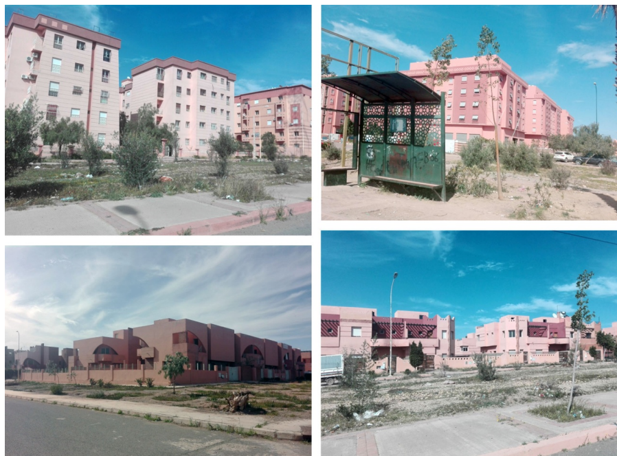
Figure 38 : Un manque d'entretien des espaces verts dans la ville de Tamansourt
