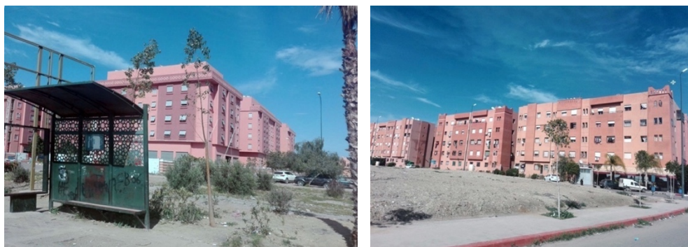
Figure 109 : Exemples de façades de projets de logements collectifs
