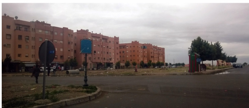
Figure 40 : Tamansourt : État des espaces verts d'un des trois axes principaux
