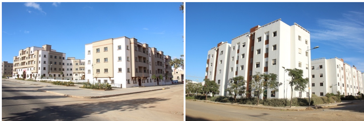
Figure 70 : Exemples de logements économiques à Sahel Lakhiayta (à gauche Opération Alrihane, à droite opération Assanoubar)
