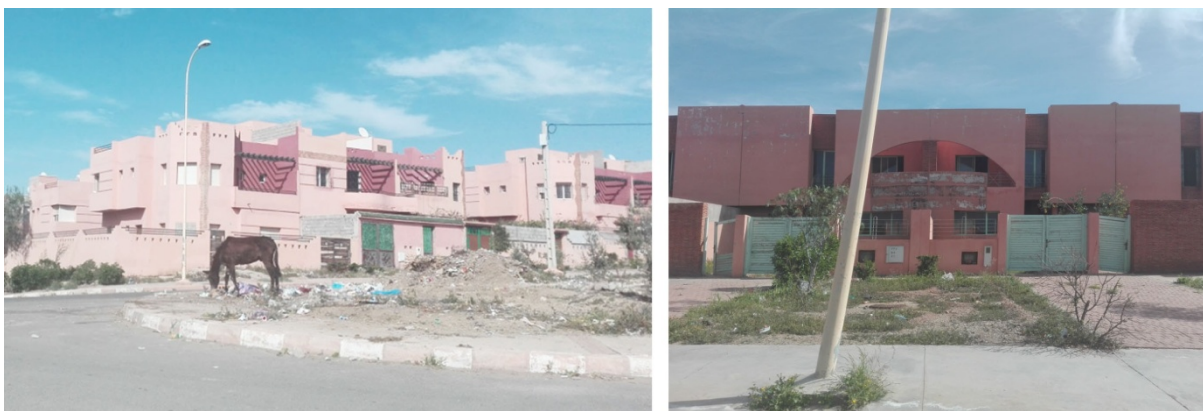
Figure 138 : Exemples de villas en état de délabrement à Tamansourt
