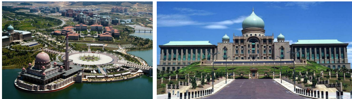
Figure 178 : De gauche à droite : 1. Putra Mosque, principale mosquée à Putrajaya
