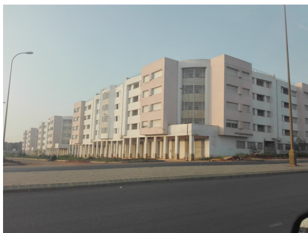
Logements économiques, CK, 2018
