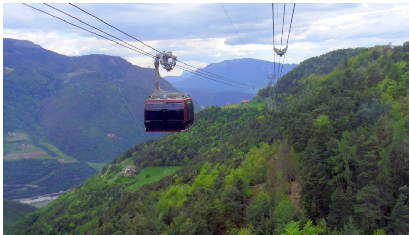
Photo n°38 : L'actuel 3S du Renon mis en service en 2009. © D. Giney, 2016
