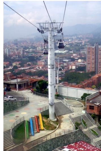
Photo n°52 : Autre exemple d'aménagement autour des pylônes © D. Giney
