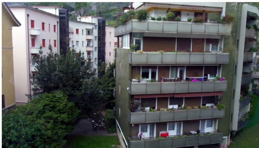
Photo n°41 : Vue, depuis la cabine, sur les immeubles riverains de la station aval. © D. Giney, 2016
