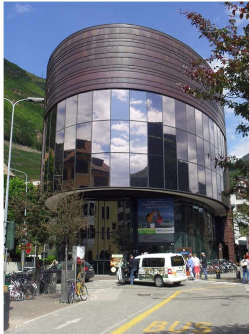
Photo n°39 : Gare aval de Bolzano. © D. Giney, 2016
