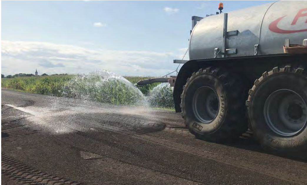
Figure V.23 Humidification de la couche d'AE
