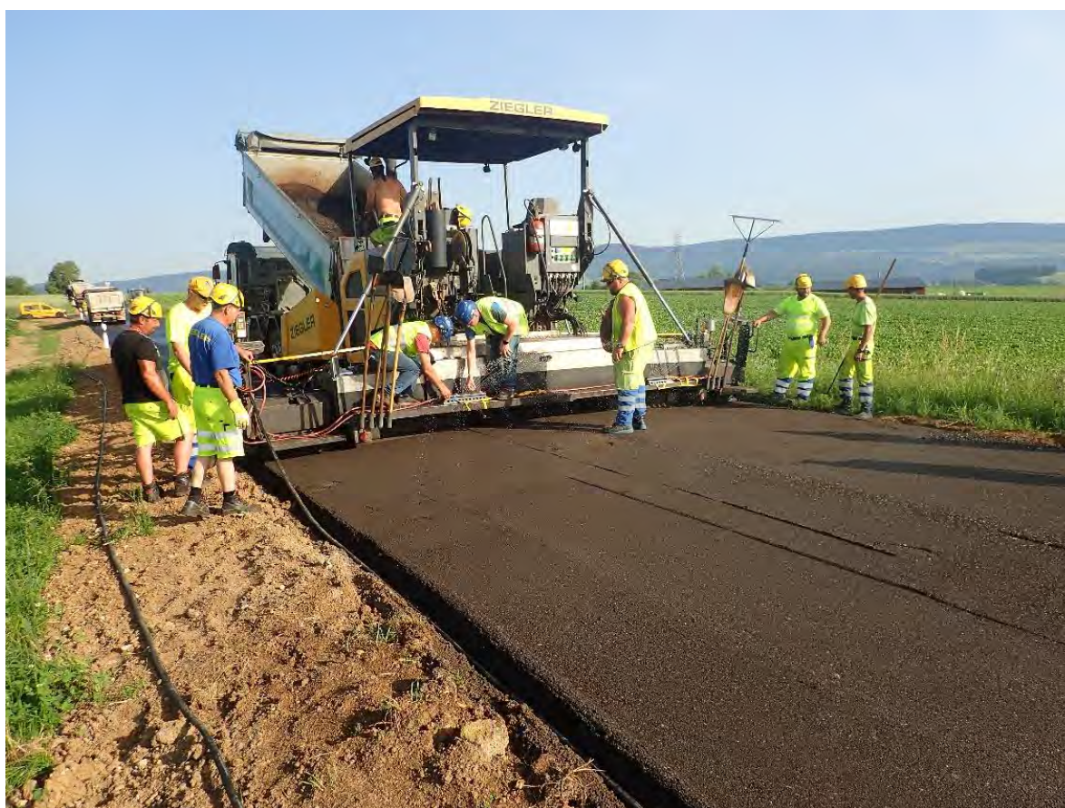
Figure V.10 Vue globale de la mise en œuvre au finisseur
