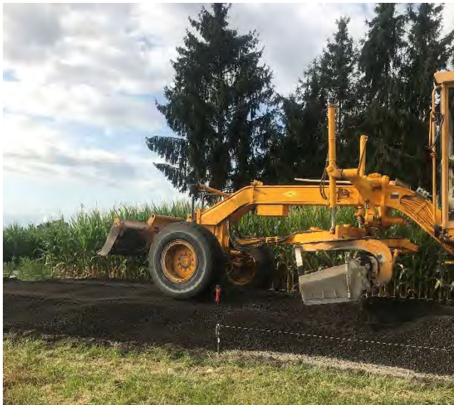
Figure V.21 Répandage des AE
