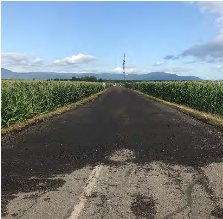
Figure V.27 Couche d'AE compactée de la section expérimentale ORRAP n°1 à la jonction avec la chaussée existante
