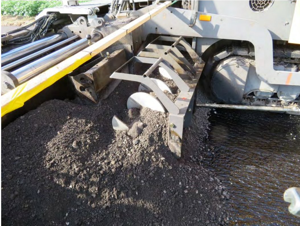
Figure V.13 Répartition des AE après leur humidification
