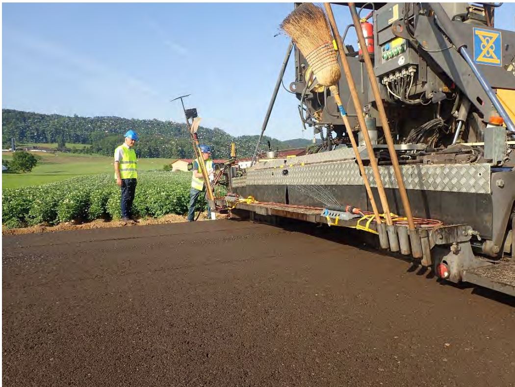
Figure V.14 Humidification des AE après répartition
