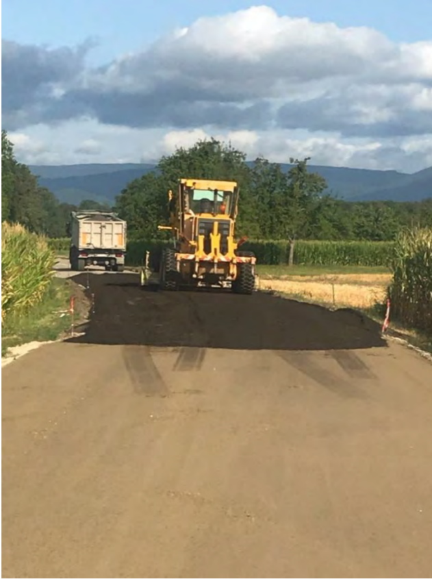
Figure V.26 Jonction entre la section témoin et la section expérimentale ORRAP n°2
