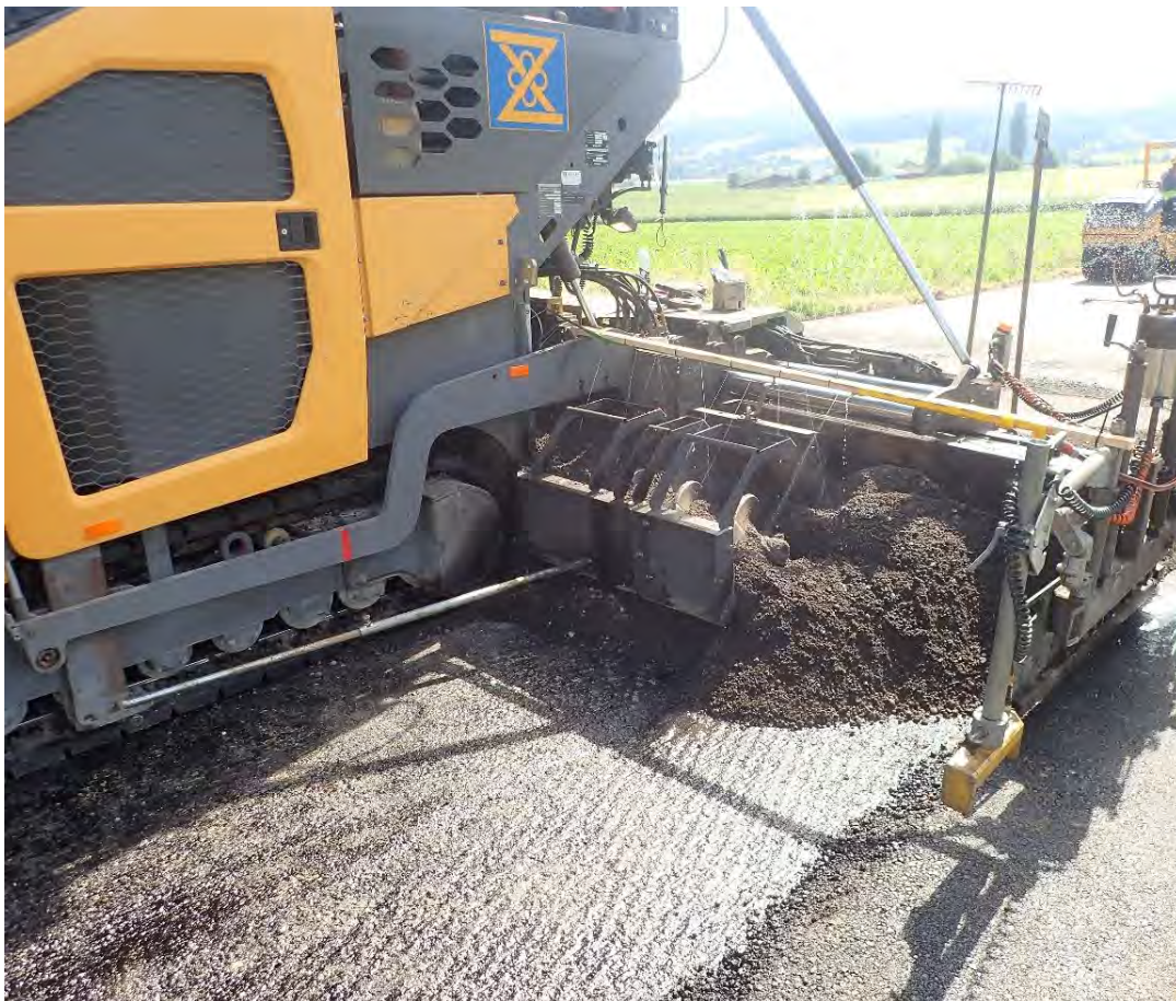
Figure V.12 Humidification des AE avant répandage
