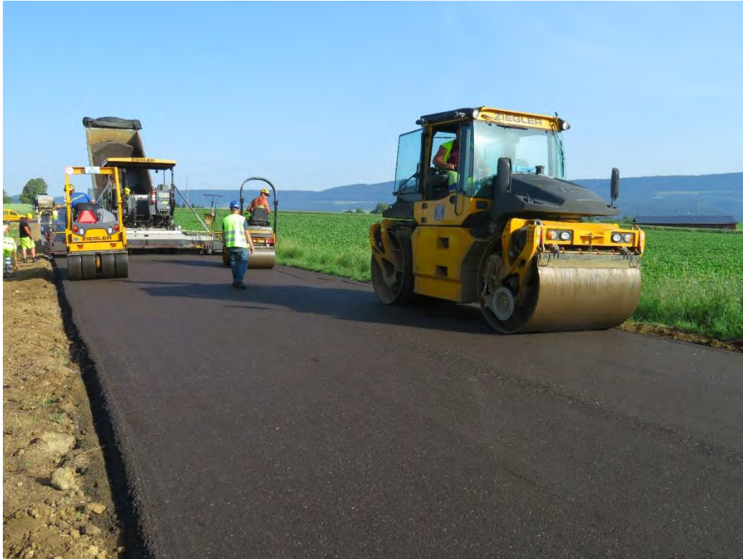
Figure V.15 Compactage à l'aide de compacteurs à cylindre et à pneus (n°1)
