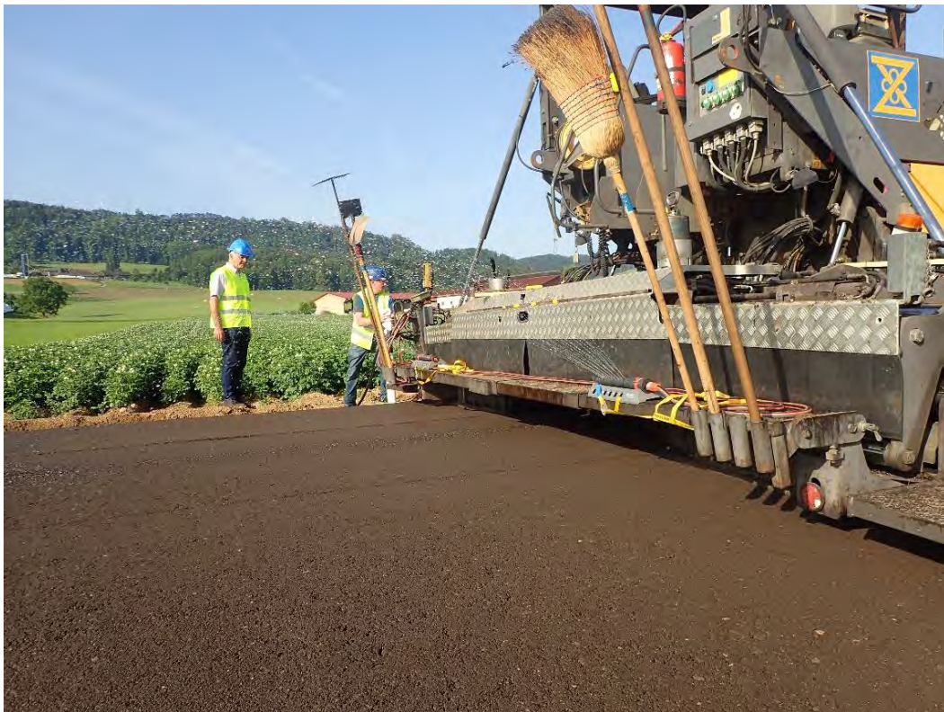
Figure V.14 Humidification des AE après répartition
