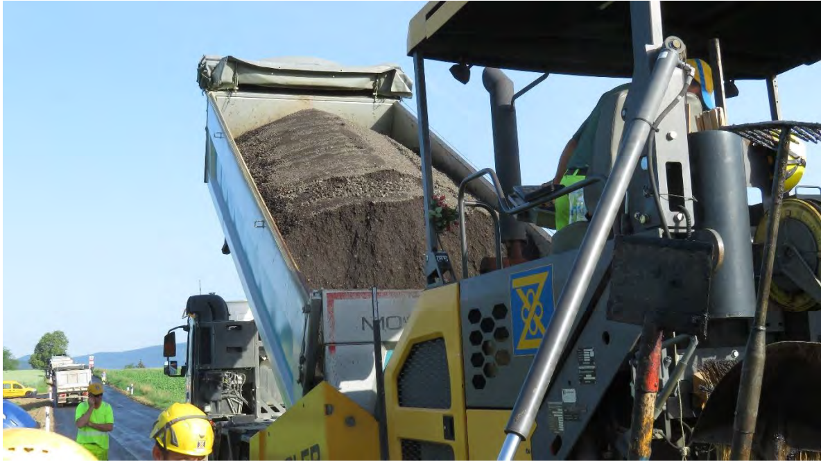
Figure V.11 Introduction des AE dans le finisseur
