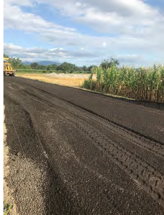
Figure V.22 Couche d'AE lissée
