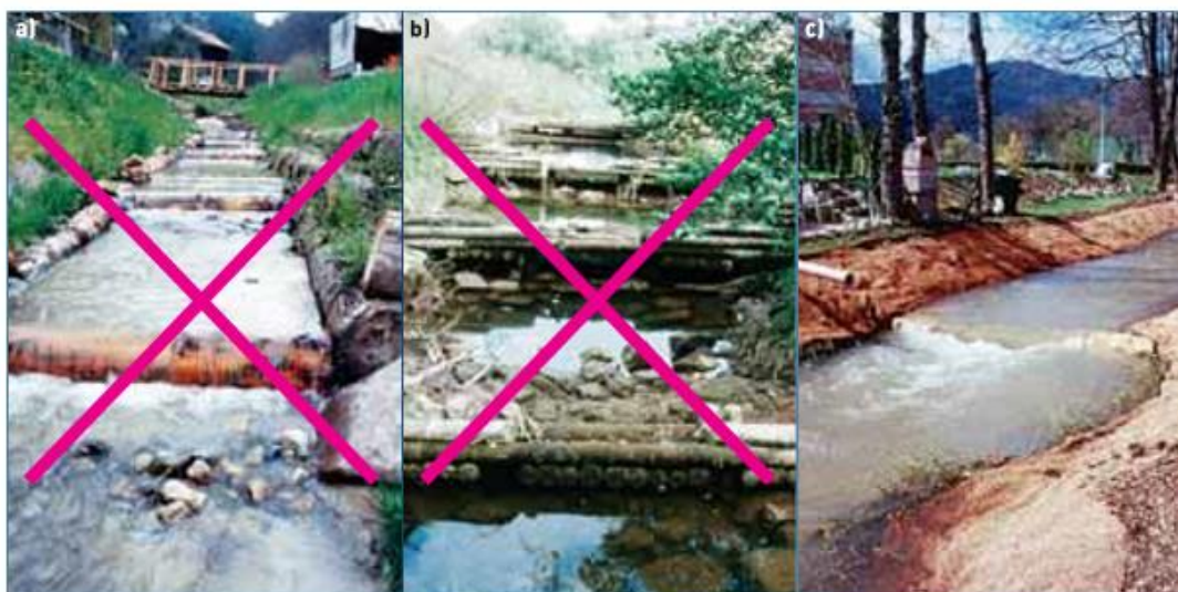
↑ Figure 22 : a) et b) Seuils en rondins de bois (à déconseiller). c) Seuil en enrochement (à conseiller). En effet, selon nous, la mise en place de seuils en enrochements permet un rendu plus respectueux des processus naturels, en limitant la largeur de la lame d'eau. ≡
