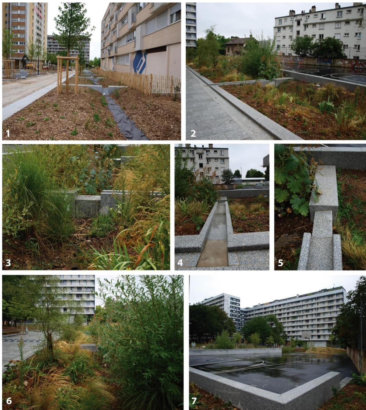
Figure 7.13 Photographies des noues, quartier de la Noue
