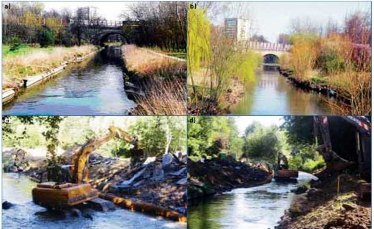
↑ Figure 54 : Vue d'une partie du secteur restauré. a) Avant les travaux (photo Biotec). b) En 2007. c) et d) Suppression des protections en béton (photos SIVOA). ≍
