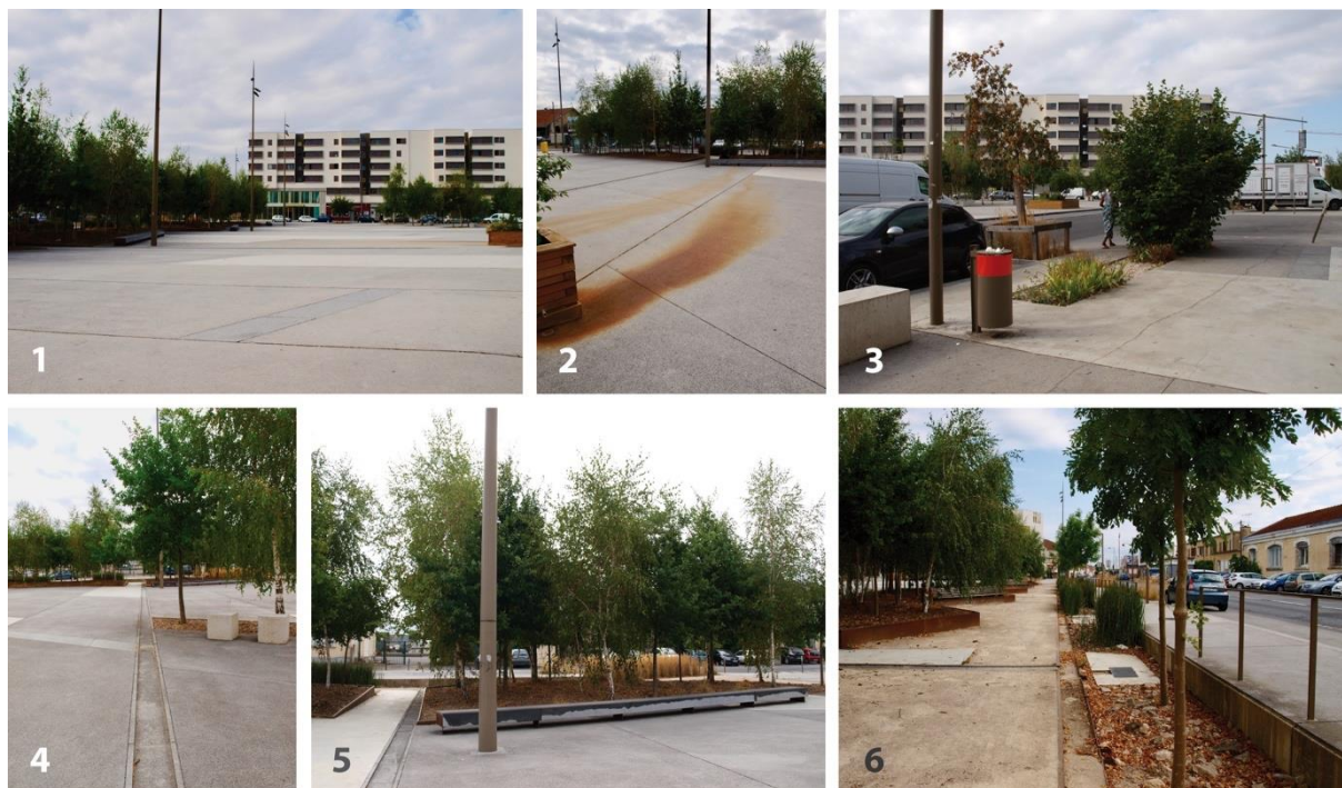
Figure 7.25 Photographies de la Place Lorca, une place minérale équipée pour gérer ses eaux de ruissellement, quartier Clause Bois Badeau
