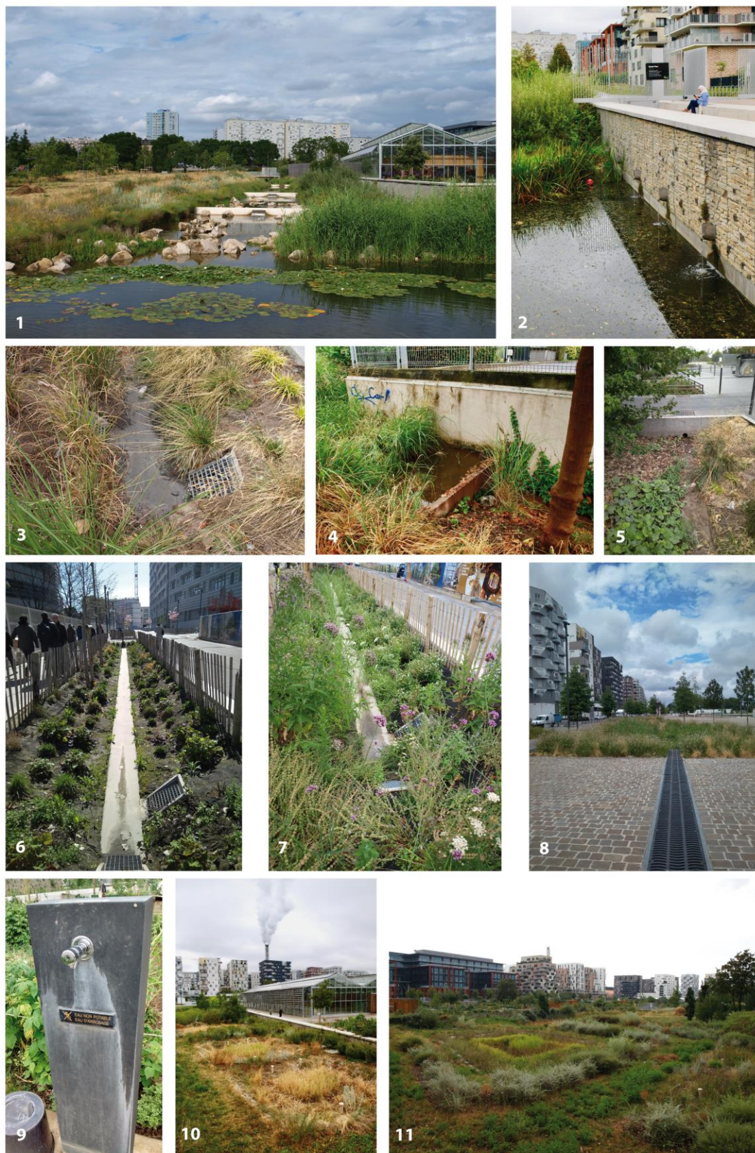
Figure 7.22 Photographies des bassins, noues et ouvrages de gestion des eaux de pluie dans le quartier des Docks
