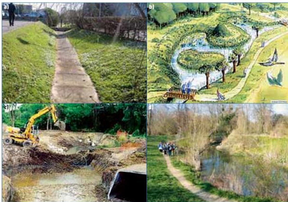
↑ Figure 57 : Vues du secteur restauré. a) Amont du secteur restauré. b) Esquisse du projet. c) Travaux de réouverture [2003] (noter la présence d'une partie du collecteur à droite) [source b) et c) : atelier Cepage]. d) Secteur restauré (2007) [source a) et d) : Malavoï]. ≈
