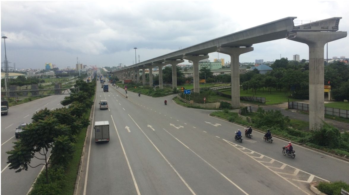
Photo 10. La ligne 1 en construction du réseau de métro de Hô Chi Minh Ville (en parallèle de la route nationale n° 52)
