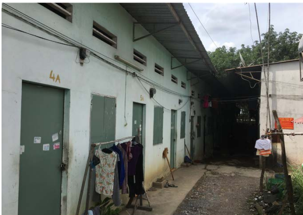
Photo 20. Un dortoir de petite taille construit sur des espaces inoccupés d'une maison-compartiment (district de Tân Uyên, Binh Duong)
