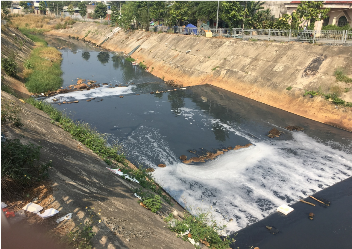
Photo 26. Les eaux usées d'une usine située dans le sous-district Binh Tho (district de Thu Duc, Hô Chi Minh Ville) déversées dans un canal traversant un secteur résidentiel
