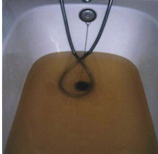
Figure 10 : Exemple d'eau brune provenant d'un robinet d'eau domestique. Photographie tirée de Vreeburg et Boxall 2007.
