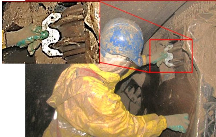
Fig. 1.27. Opérateur au niveau de la roue de coupe du tunnelier analysant l'usure des disques 57 .
