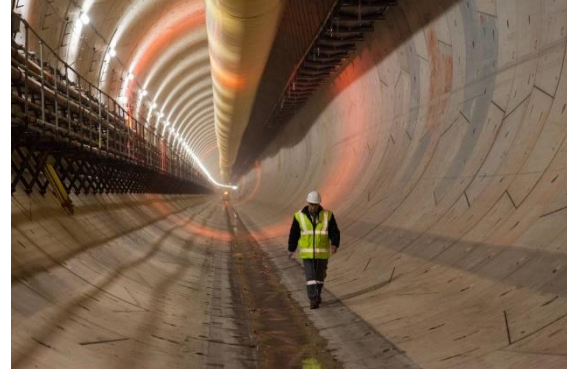
(b) Revêtement du tunnel
