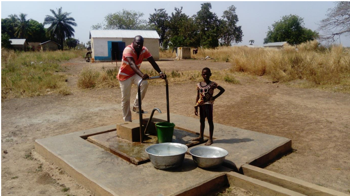
Figure 6.9 – Photographie du forage F2 du site Saré en exploitation, implanté sur la base d'une section ERT.
