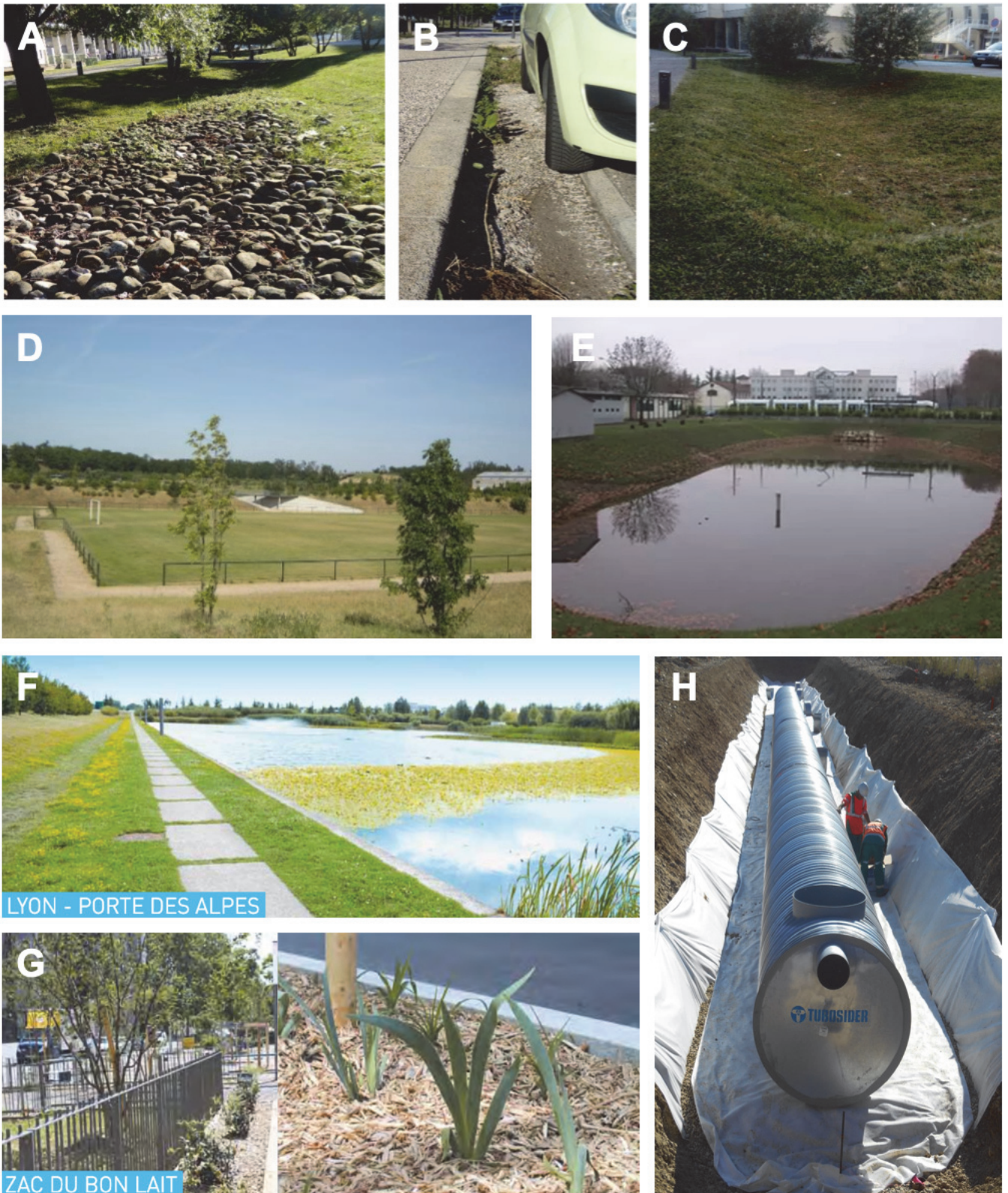
Figure 2.2. Aménagements urbains permettant l'infiltration des eaux pluviales. A) rivière sèche, B) tranchée drainante, C) noue végétalisées, D) terrain de football, E) bassin d'infiltration, F) lac artificiel, G) bande végétalisée et H) buse drainante. Crédits photos : A-C Hélène Bouteiller (Stagiaire M2 2017), D-E http://www.graie.org/ , F-G https://www.grandlyon.com/ , H https://www.tubosider.fr/ .
