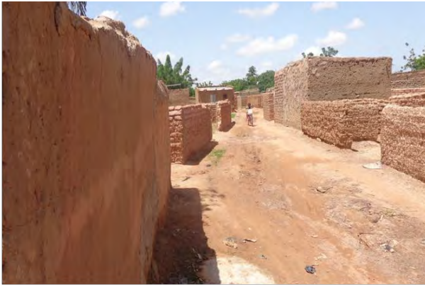
Non-loti, quartier Djicoffè
