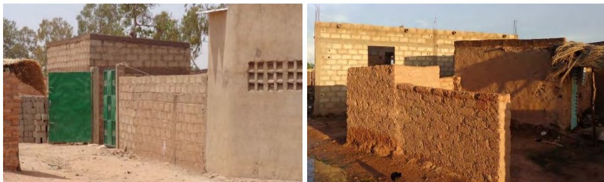
Planche photographique 2: Construction en dur en non-loti, Tabtenga
