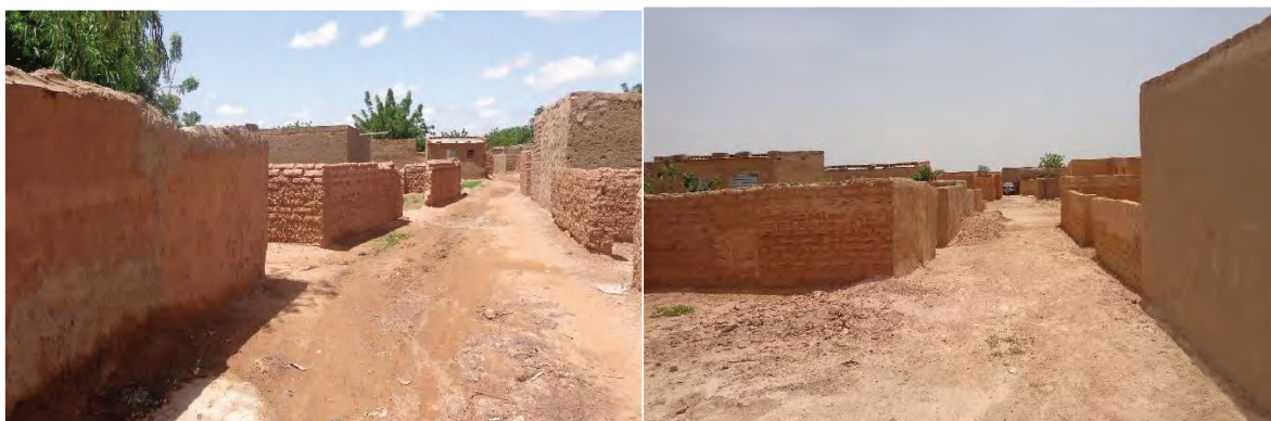
Habitat spontané, non-loti à Tabtenga, Arrondissement 10 (photo 1) et Boassa Arrondissement 7 (photo 2)
