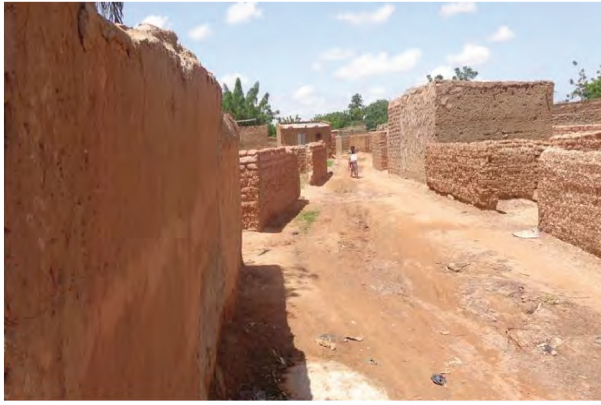
Non-loti, quartier Djicoffè
