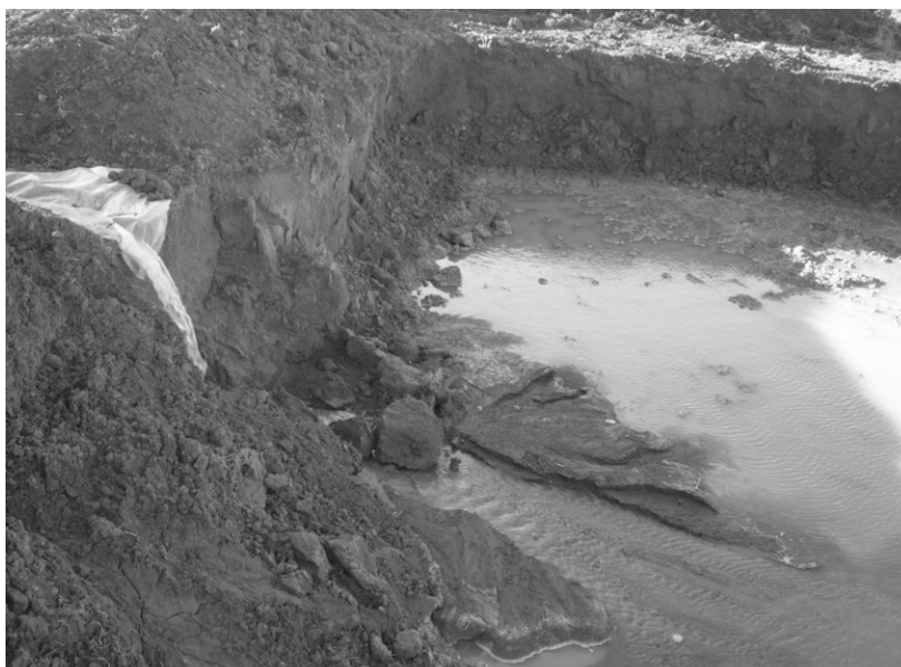
Figure 74. Bassin d'eau en terre en cours de remplissage utilisé par les locataires.
