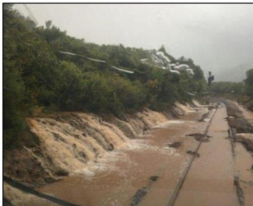
FIGURE I-42: INONDATION DE LA VOIE PAR DES EAUX DE RUISSELLEMENT
