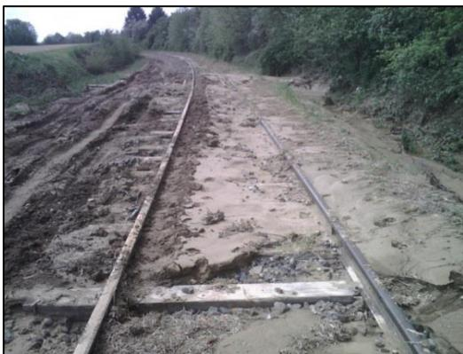
FIGURE I-43: DEPOTS DE BOUE APRES LE PASSAGE D'EAUX DE RUISSELLEMENT
