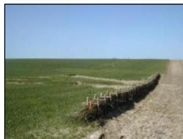
**FIGURE I-38: FASCINE PLACEE EN TRANSVERSALE PAR RAPPORT AUX ECOULEMENTS (SOURCE : FICHE SYNTHÈSE DE L'AREAS N°12)**
