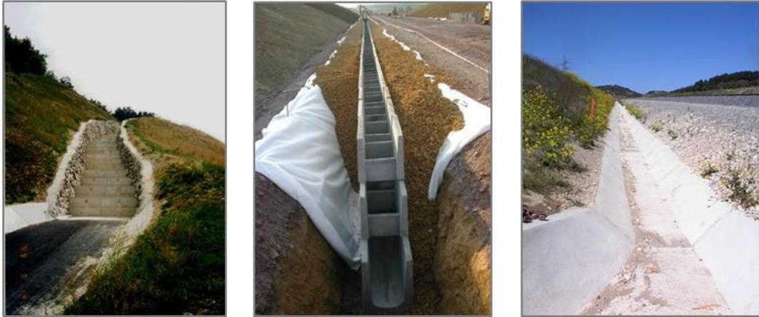
FIGURE I-35: EXEMPLES DE DISPOSITIFS DE DRAINAGE (DE GAUCHE A DROITE: DESCENTE D'EAU GRAND DEBIT, FOSSE BETON PREFABRIQUE A BARBACANE, FOSSE REVETUE A CIEL OUVERT)
