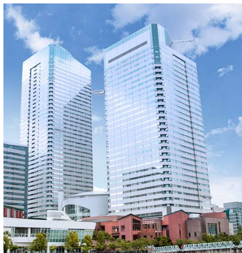
Figure 4.1 : Structures de grande hauteur connectées par un actionneur (Triton square complex, Tokyo, Japon [101]).
