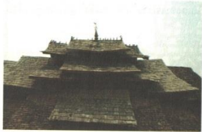
▲ วิหารวัดหนองไหล่งมุงหลังคาด้วยแผ่นเงิน
