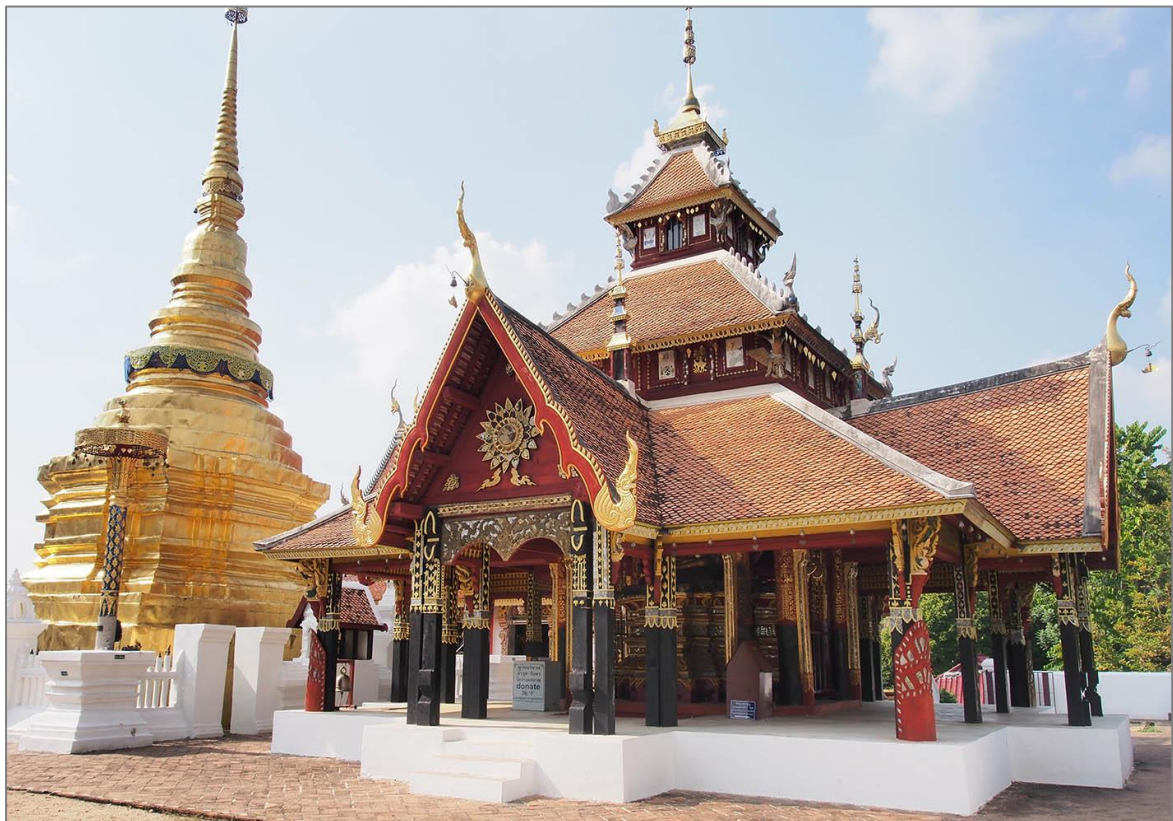
Figure 43. Le résultat du projet de restauration mené par l'association LPC
