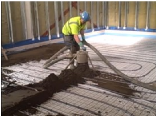
Figure 124 Technique du tirage de chape
