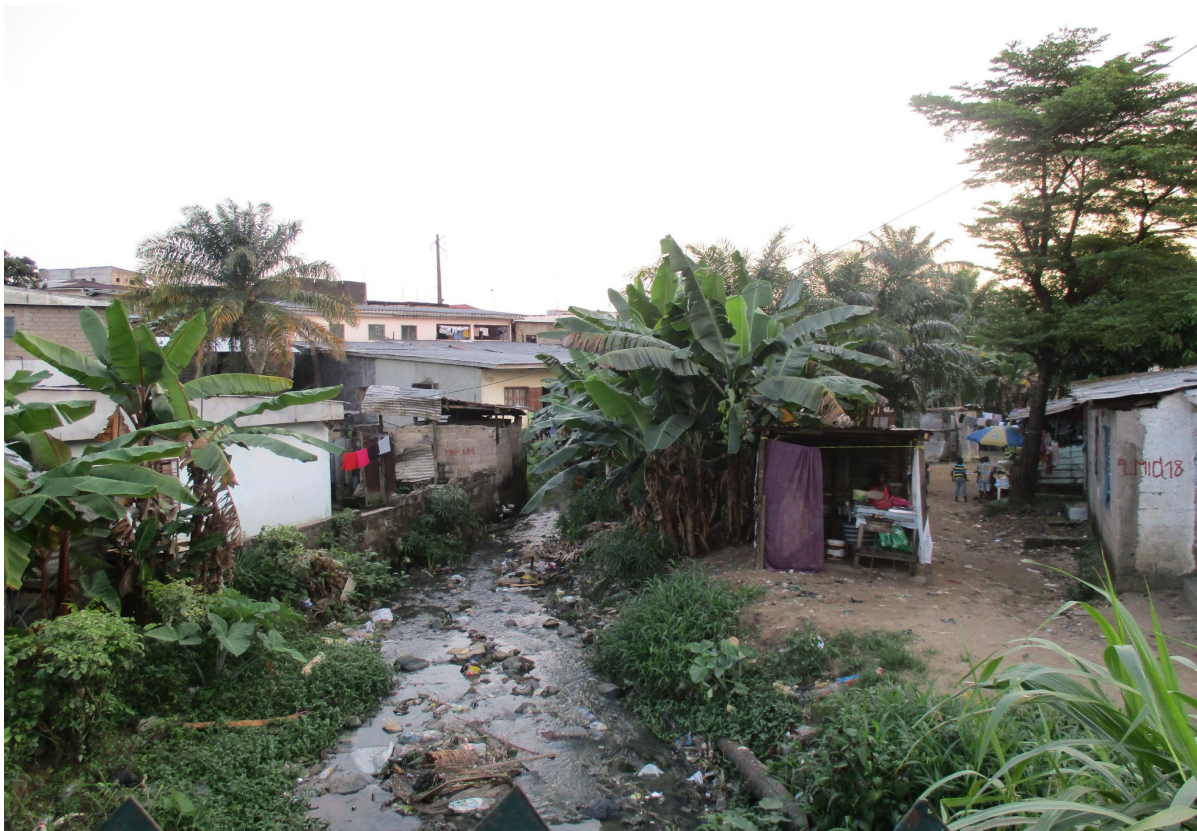
Figure 60 : Photographie du drain Mbanya, Déido, Vallée des Trois Boutiques, Bessengue, [Ghattas, Douala, 2016].
