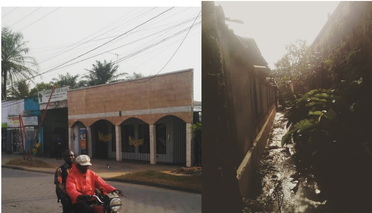
Figure 64 : Photographie du drain de Bonassama à Bonabéri, [Ghattas, Douala, 2018].
