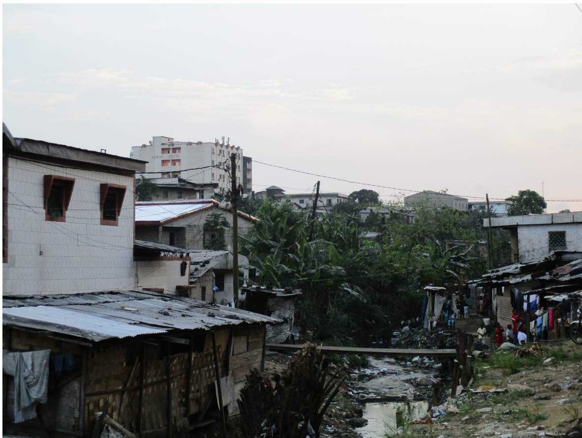
Figure 61 : Photographie du drain Mbanya, Déido, Vallée des Trois Boutiques, Bessengue, [Ghattas, Douala, 2016].
