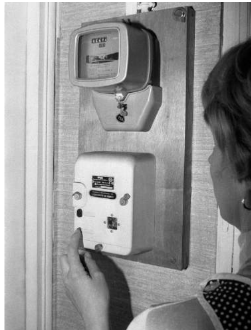
Fig. 11 — Un compteur bleu électromécanique dans le domicile d’une cliente 2 (Source : AGIP/Bridgeman Images, 1975)
