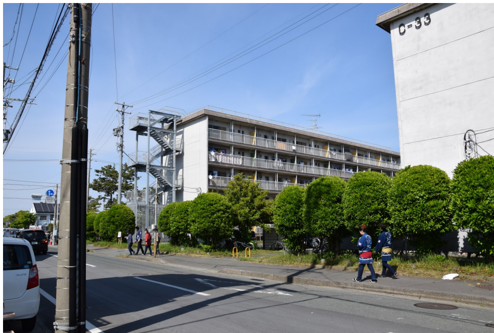
FIGURE 3.17 – Bâtiment de logement diagnostiqué et aménagé pour l'évacuation face à un tsunami, plage d'Hamamatsu, Japon.
