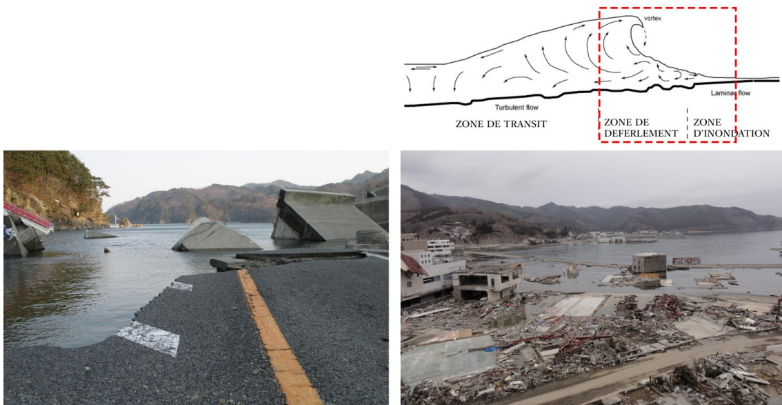
FIGURE 1.19 – Affaissement -ou subsidence- et tassement des sols : Kensennuma, Japon, tsunami du 11 mars 2011.
