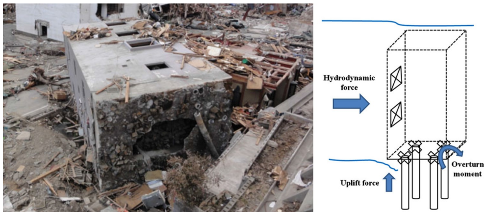
FIGURE 1.26 – Immeuble en béton armé de 4 étages arraché dans la ville d'Onagawa (photo du 29/03/2011) et schéma du mécanisme d'arrachement.
