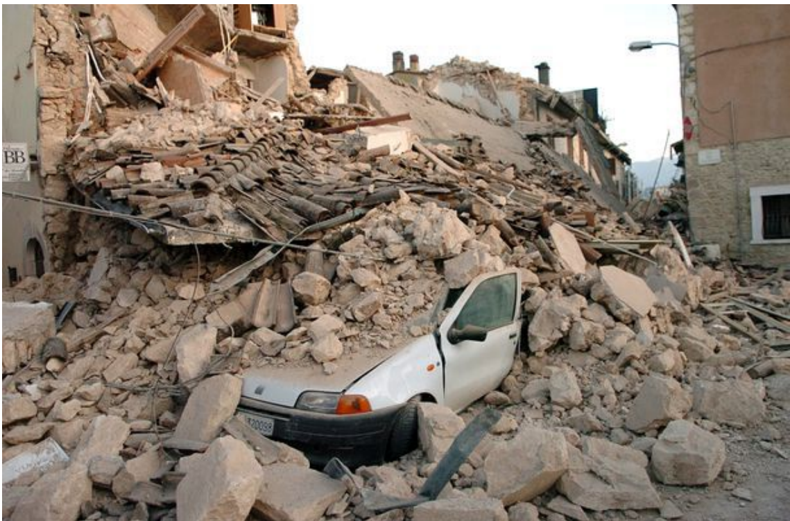
FIGURE 5.1 – Photographie de dommages suite au tremblement de terre de l'Aquila (Italie) en 2009.
