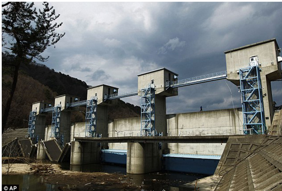
FIGURE 3.7 – Porte anti-tsunami à l'embouchure d'une rivière à Fudai, Japon, permet de faire la jonction des digues et évite la remontée rapide du tsunami par les cours d'eau. Sources : A.P., 2011.
