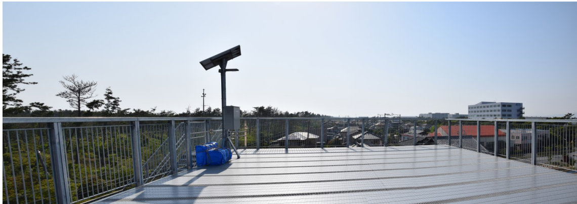
FIGURE 3.12 – Plateforme d'une tour d'évacuation pour tsunami avec une cantine contenant des objets de première nécessité et premiers soins ainsi qu'un téléphone avec panneau solaire, à Hamamatsu, Japon.
