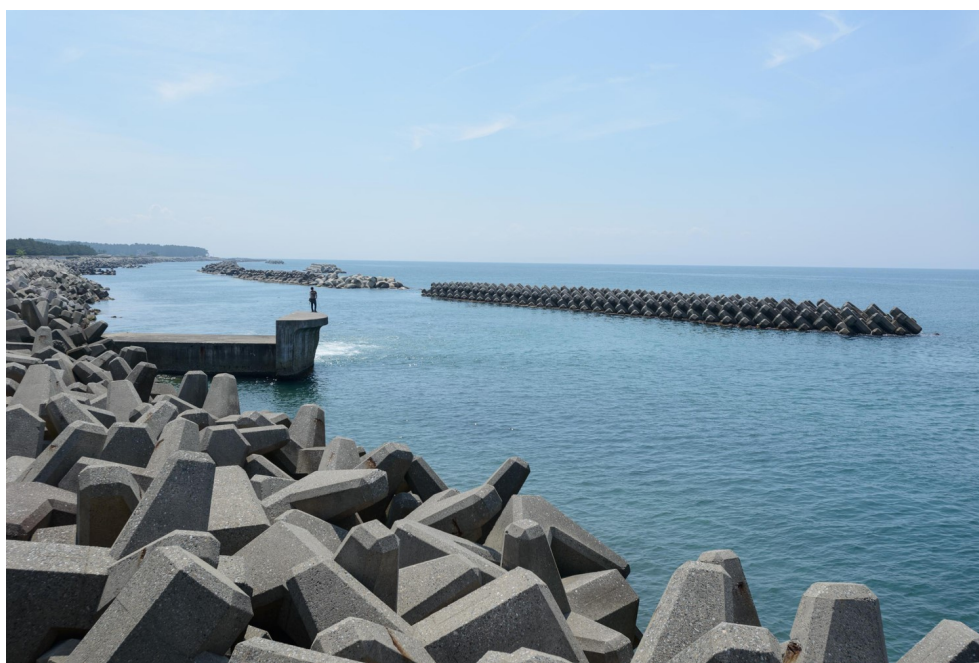
FIGURE 3.5 – Tétrapodes (blocs de béton) sur le littoral et en contrefort d'une digue à Kurobe, Japon.
