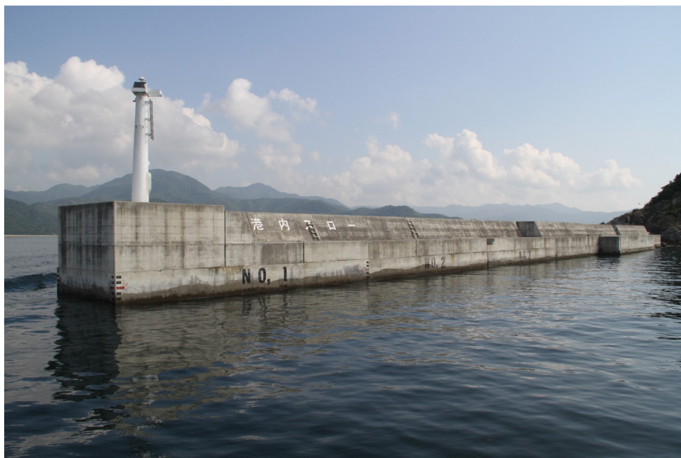
FIGURE 3.4 – Brise-lame au large du front de mer à Nobeaka, Japon. Situés aux embouchures des ports ou des zones à enjeux, afin de provoquer le déferlement et donc la perte d'énergie du tsunami.
