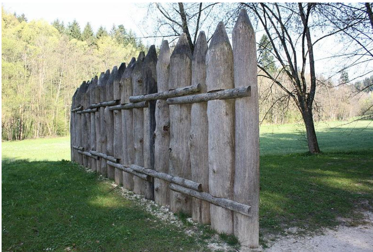
Fig. 042 : Reconstruction de la palissade du limes germanique à Rotenbachtal (Schwäbisch Gmünd), photographie sous licence Creative Commons Consulté le 17.04.2011. URL : http://commons.wikimedia.org/wiki/File:Obergermanischer_Limes_Schw%C3%A4bisch_Gm%C3%BCnd.jpg?uselang=fr
