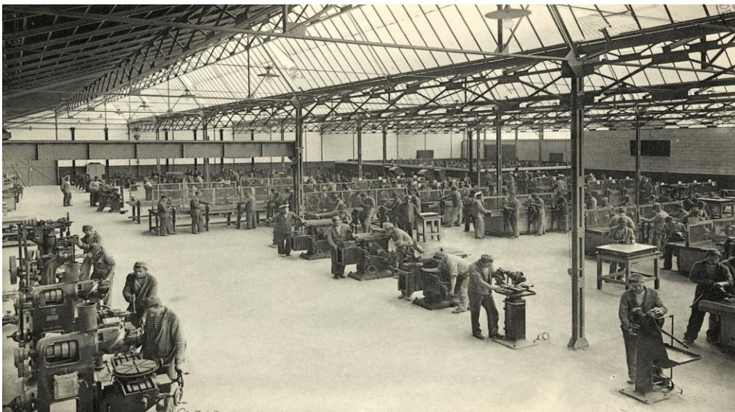
L'atelier d'ajustage : un atelier vaste et bien éclairé. Les machines y sont nombreuses, la mécanisation poussée, la transmission électrique. Chaque poste de travail comporte une tête mécanique. Les apprentis mécaniciens de la Marine bénéficient d'un fort encadrement.
