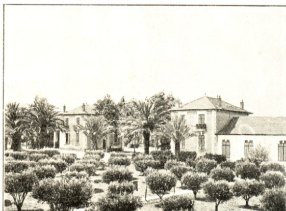
Vue générale des bâtiments et champ d'orangers
