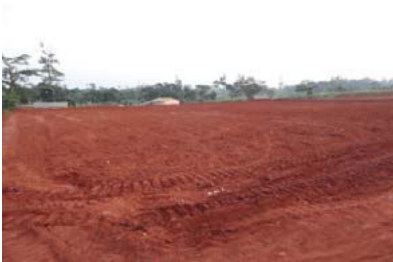
Photo 49: Un stade de football en construction pour les employés.
