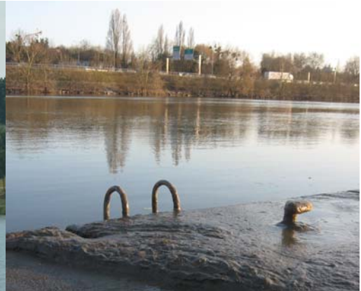
Figure 63 : Limon déposé sur le quai après une crue de la Maine (Photographie : Bodénan, 2012)
