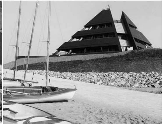
Figure 81 : Infrastructure du Lac de Maine en 1977 (Photographie : Mornet)
