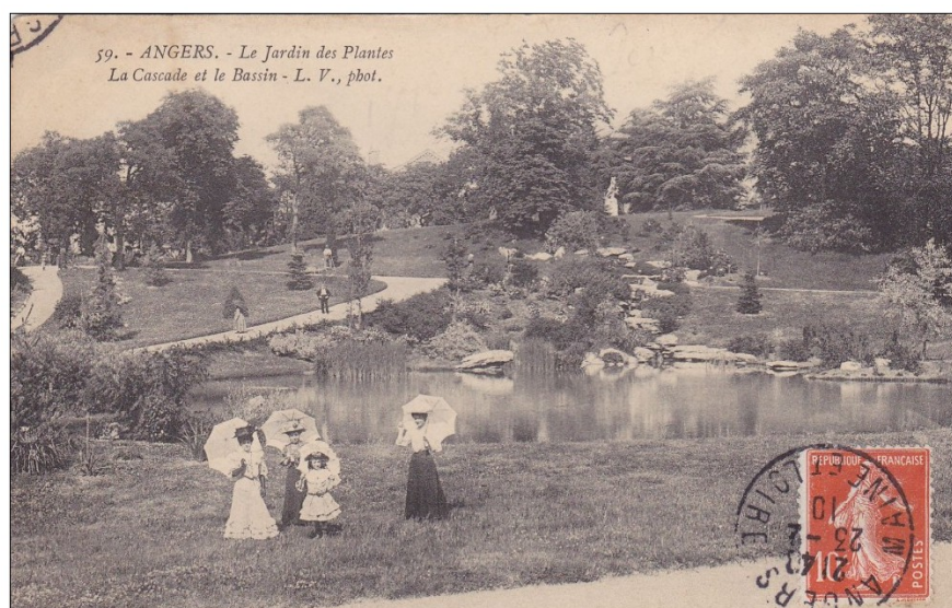
Figure 46 : Le Jardin des Plantes, de style pittoresque (Carte postale ancienne : « L.V. », vers 1910)
