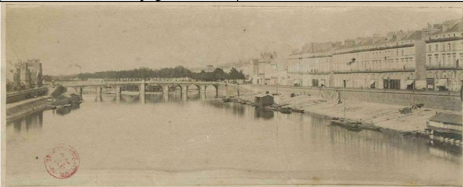
AUTEUR INCONNU, fin XIXème, Le pont du Centre, vue prise en aval, et le quai Ligny, en rive gauche de la Maine , Archives départementales de Maine et Loire (11 Fi 0658)
