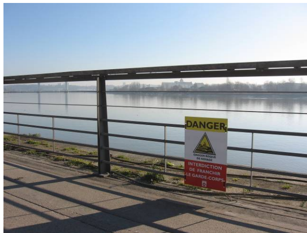
Figure 148 : Garde corps en limite du quai à Bordeaux (Photographie : Bodénan, 2013)
