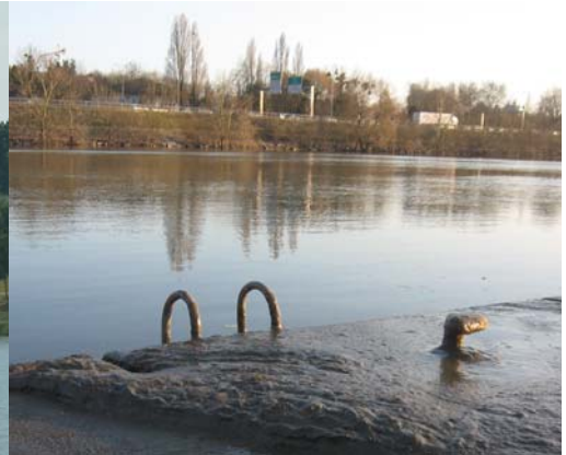
Figure 63 : Limon déposé sur le quai après une crue de la Maine (Photographie : Bodénan, 2012)
