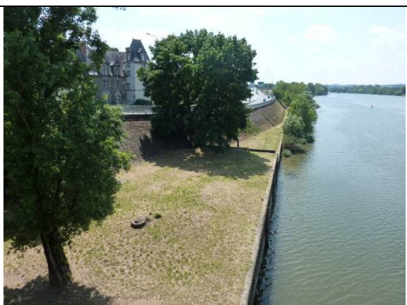
BODENAN Philippe, 2013, Angers, rive gauche, Hôtel du roi de Pologne, photographie
