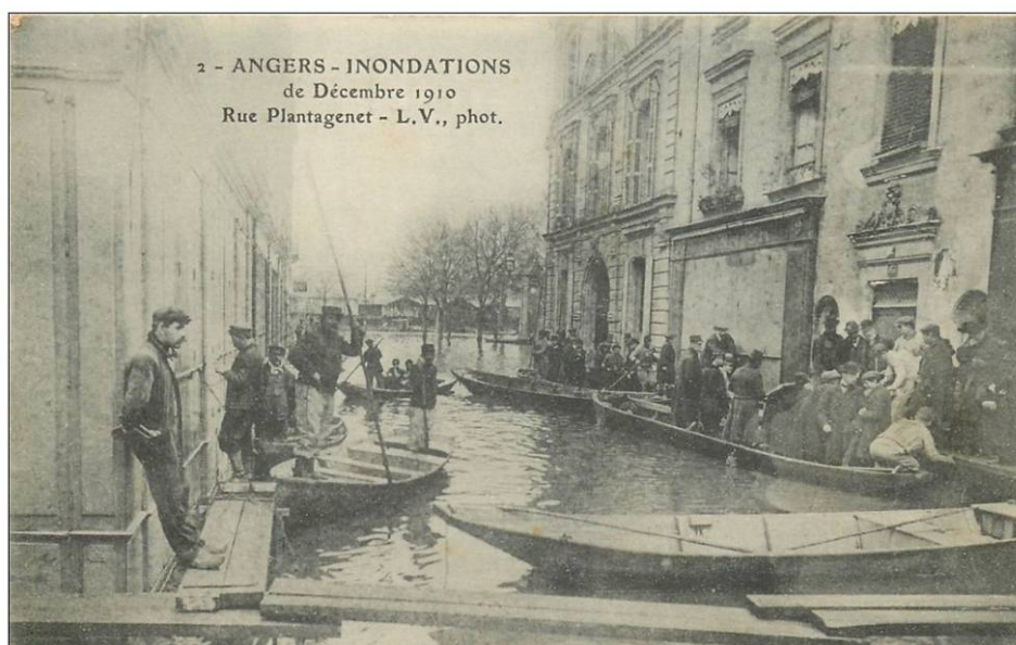
Figure 74 : La crue de 1910 dans la partie basse de la ville (Carte postale ancienne : « L.V. », 1910)
