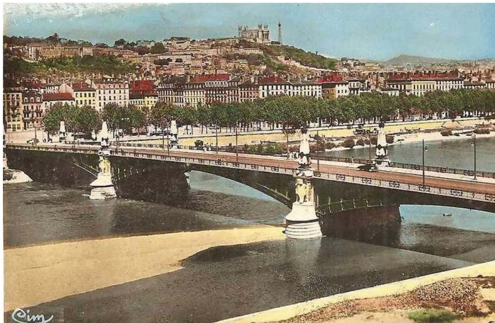
Figure 133 : Bancs de graviers émergeant autrefois dans le lit du Rhône et désormais masqués par le relèvement du niveau d'eau du au barrage de Pierre Bénite 3 . (Carte postale : éditions CIM, vers 1970)
