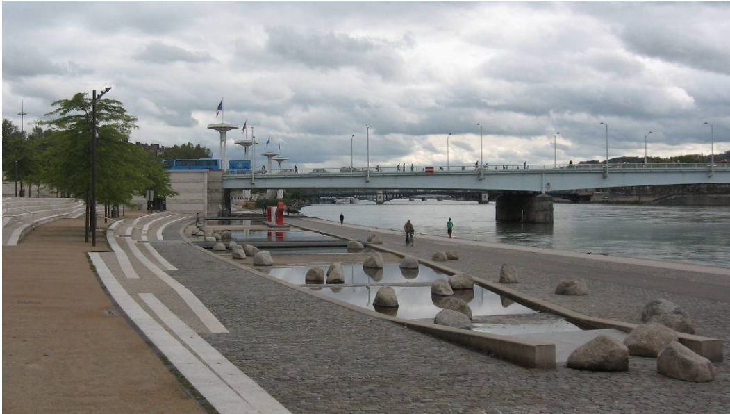
Figure 144 : Bassin représentant une lône (bras du Rhône) à Lyon (Photographie : Bodénan, 2013)
