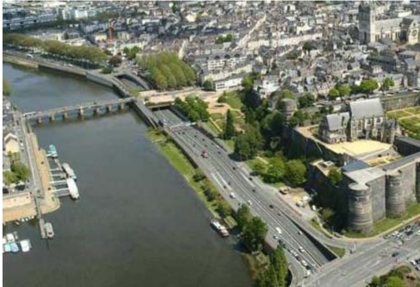
Figure 79 : Les voies sur berges au niveau du centre-ville. (Photographie : Dubray, 2011)
