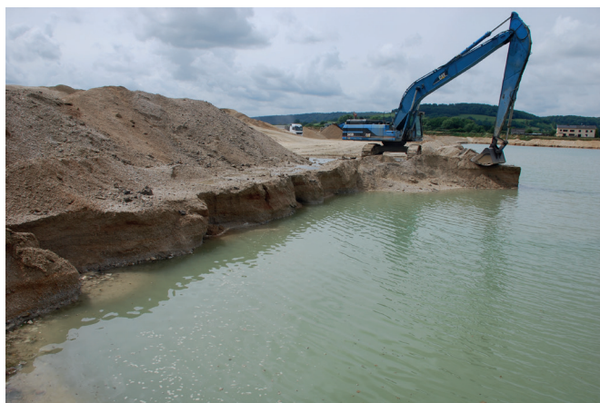
Figure 65 : Création d'un battard d'eau en limite de fouille. H.G. Naton, 2012
