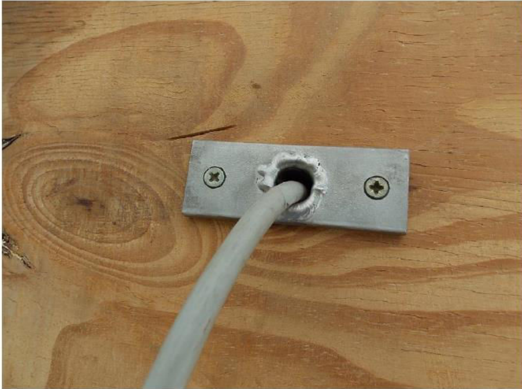
Figure 71 : Passage du câble électrique souple au travers de l'axe central de rotation des lampes. (Photo : Frédéric Pascal, INRA PACA).
