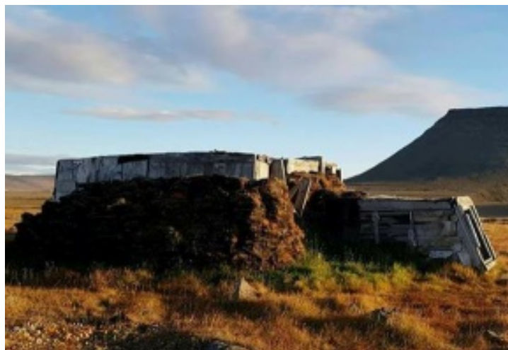
Figure 33 - Habitat ancien. Maison en pierres, terre et bois, à Thulé. Photo de S. Kristiansen
