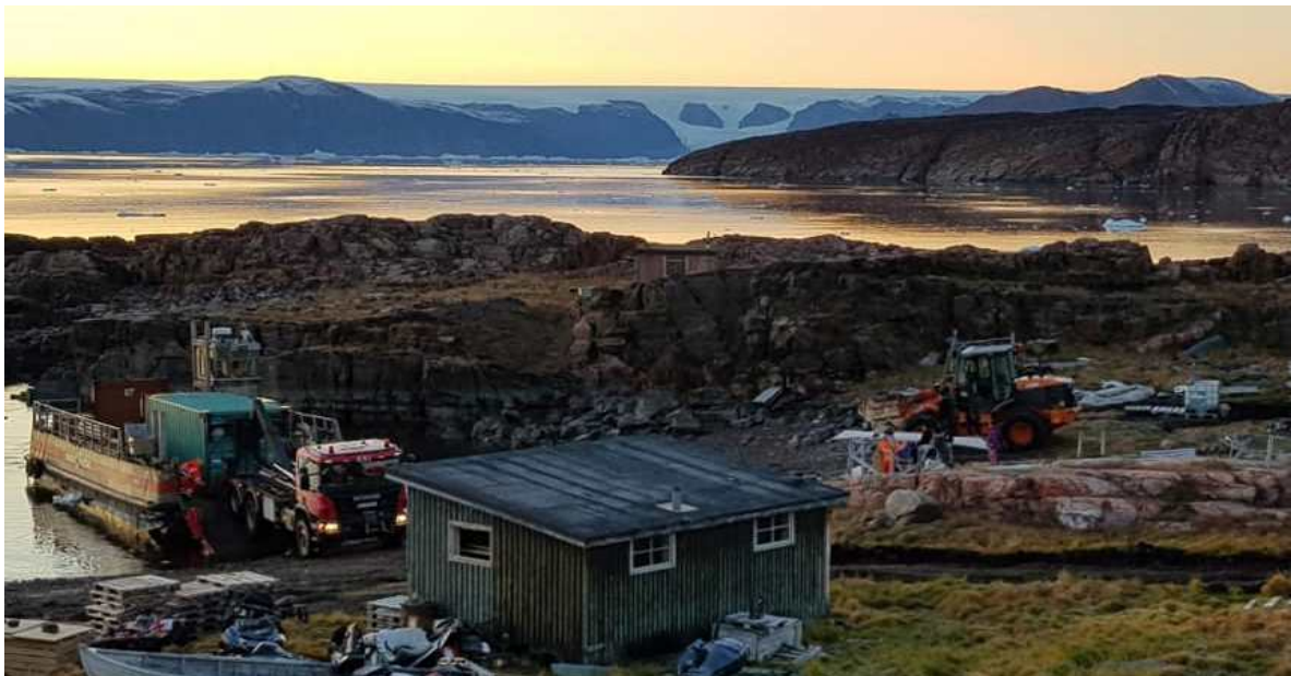
Figure 30 - Débarquement des engins de construction de la centrale électrique sur l'île de Qeqertat. 2018
