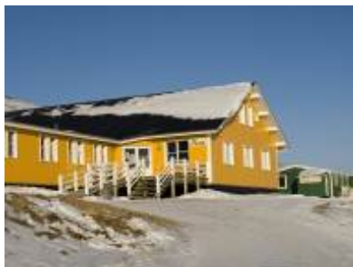
L'hôpital et la maison de retraite
