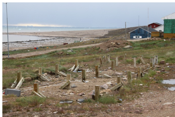
Figure 38 - Plan d'une maison de chasseur et pieux dans le pergélisol
