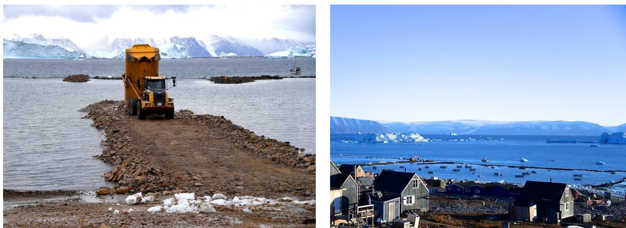
Figure 361 - Construction du port de Qaanaaq. Le 15 septembre 2018 : début des travaux, le 29 septembre 2018: les canots des chasseurs sont abrités
