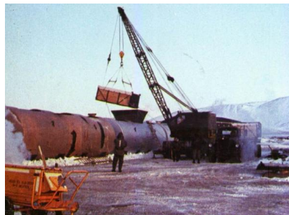
Une grue charge la glace contaminée dans des containers d'acier
