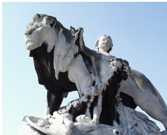
Figure 1.7 – Photographie d'une des statues du pont Alexandre III à Paris, noircie par le dépôt de suies (source AirParif).
