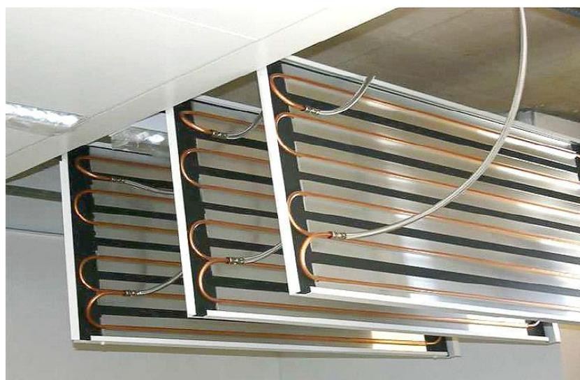
Figure 5-42 – Installation des panneaux rayonnants dans le bâtiment « Influence »
