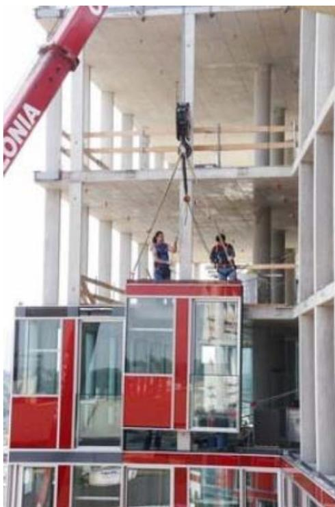
Figure 5-35 - Mise en œuvre des i-module pour l'enveloppe du « Capricorn Haus » (source : [www.architectscience.com](http://www.architectscience.com))
