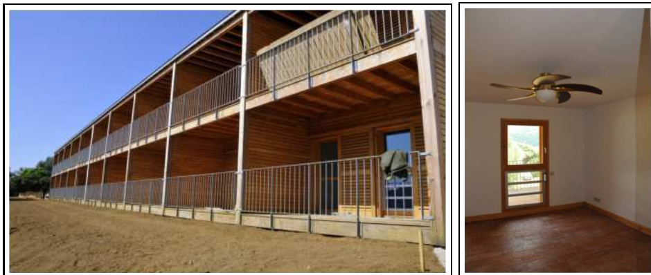
(a) Façade Est.
