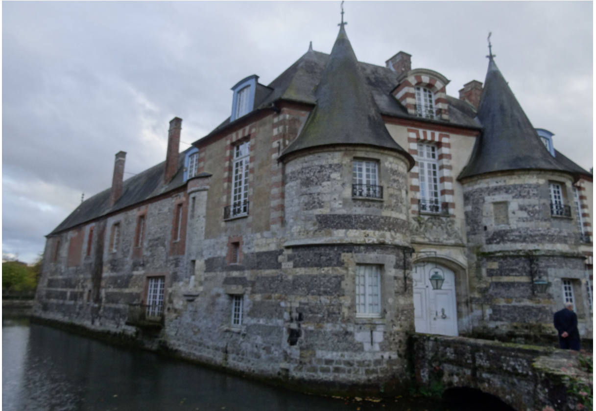
Fig. 34. Château de Mainneville. Vue actuelle du châtelet d'entrée et façade orientale
