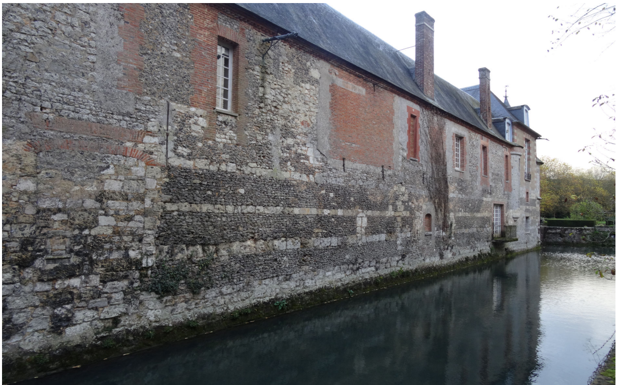
Fig. 35. Château de Mainneville Parement d'origine (Fin XIII e ) : alternance pierre de taille et tête de silex
