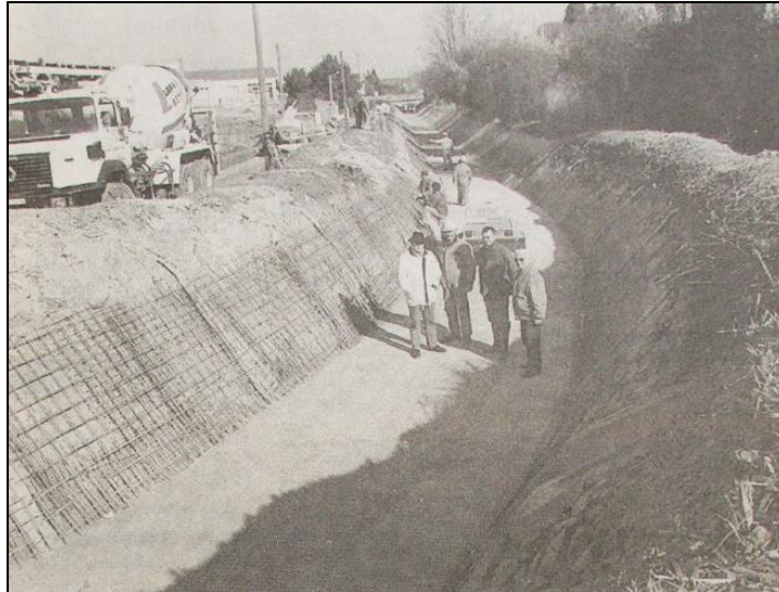
Figure 65: le canal de Pierrelatte fait peau neuve. Visite du chantier. Dauphiné libéré, 19/02/1997.
